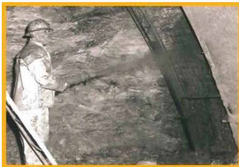
una foto di una gettata di calcestruzzo in un cantiere della costruenda Autostrada dei Fiori
