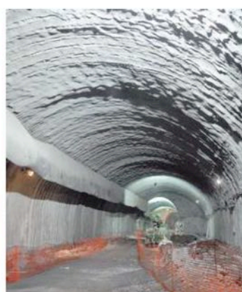
Uno dei cantieri per il raddoppio della ferrovia
