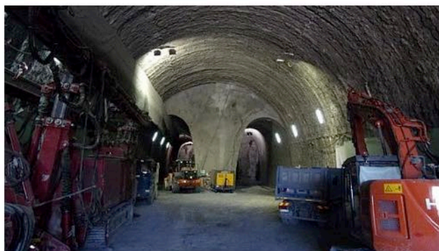
Un cantiere del Terzo Valico
