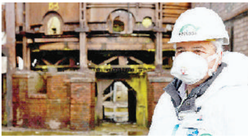
Un esperto lavora alla demolizione del complesso industriale
