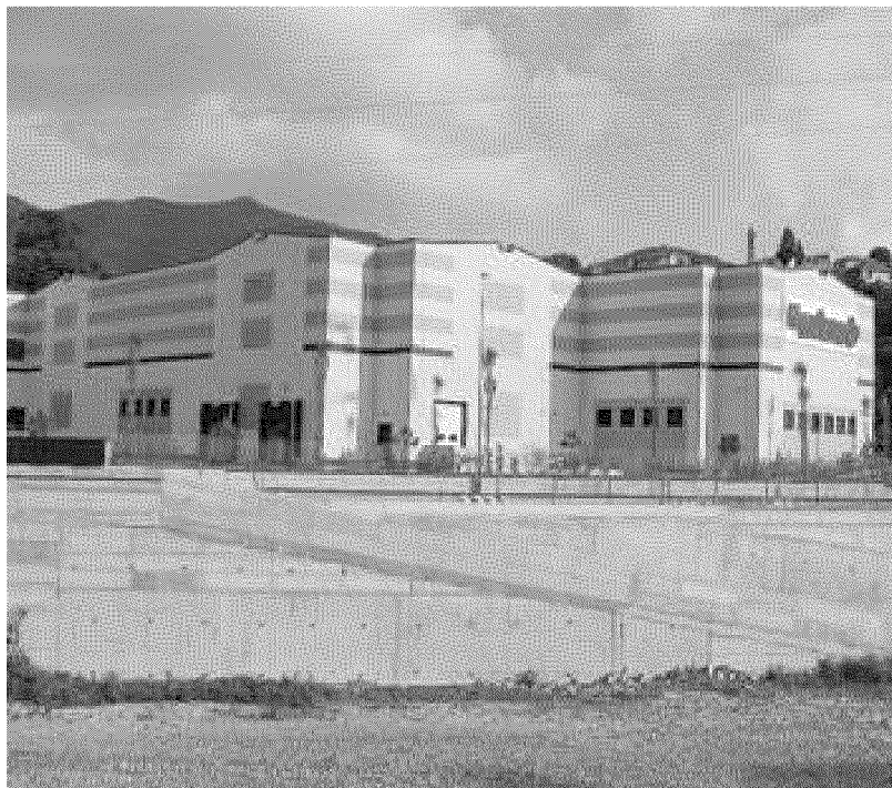
Il capannone industriale di Rio Sardorella
