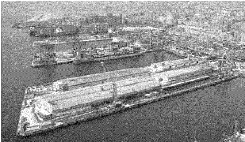
Il terminal Multipurpose nel porto di Genova visto dall'alto
