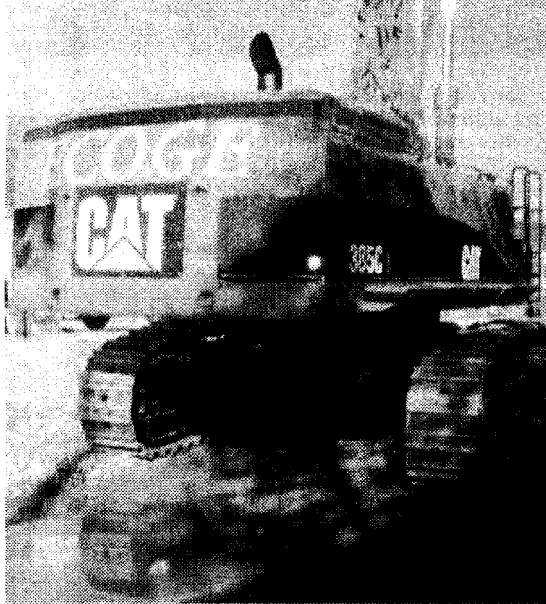
Un cantiere dell'EcoGe, l'azienda di Mamone
