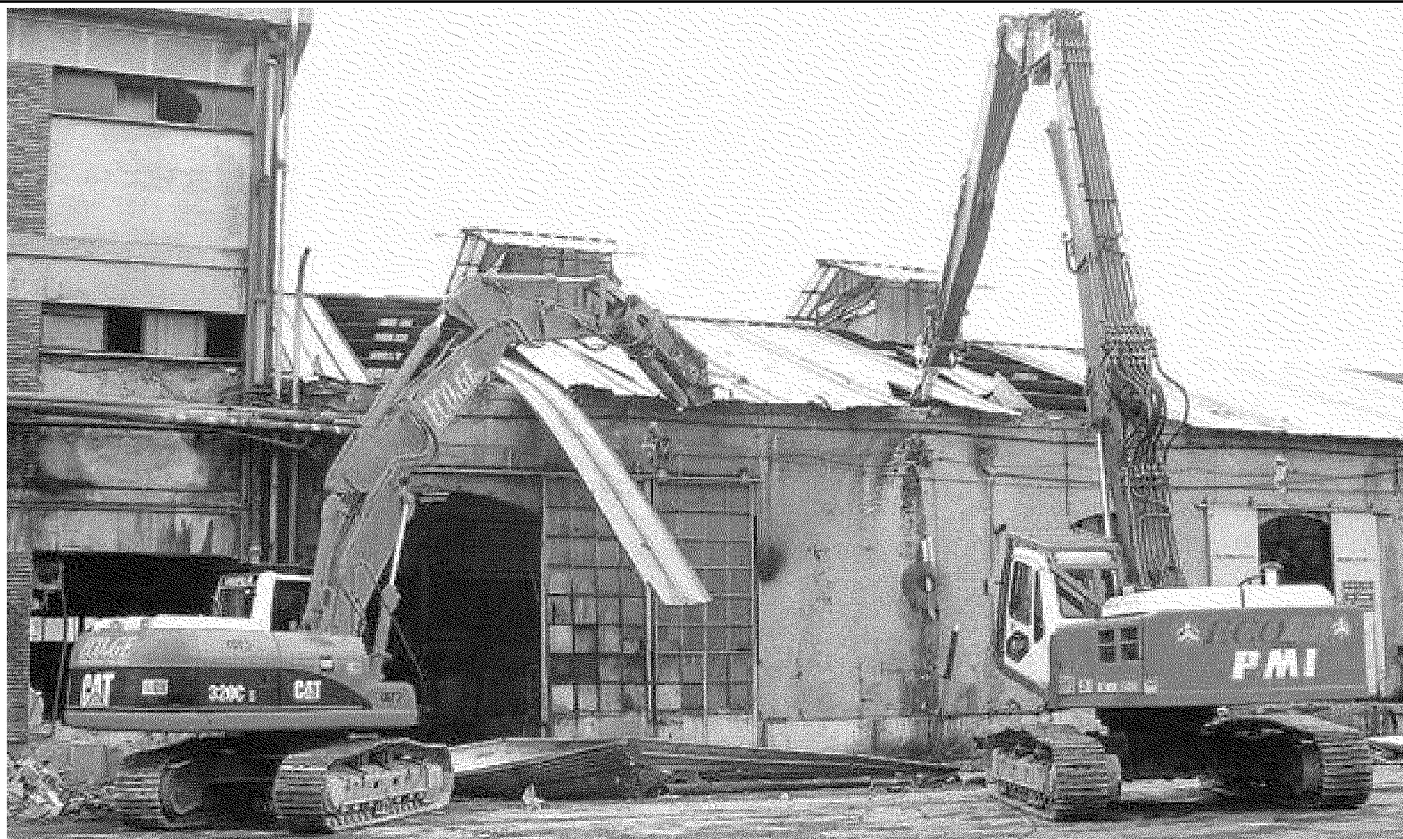
Operazioni di demolizione di un capannone nelle aree ex Ilva di Genova Cornigliano, oggi restituite alla città
