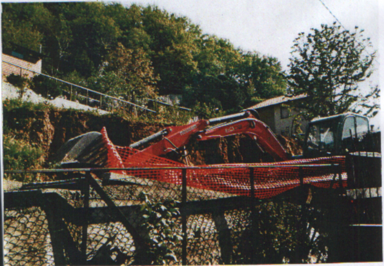
A PRUE 2007 #123 SBARCAMENTO X COSTRUZIONE MURO TAPPALE EX-75
