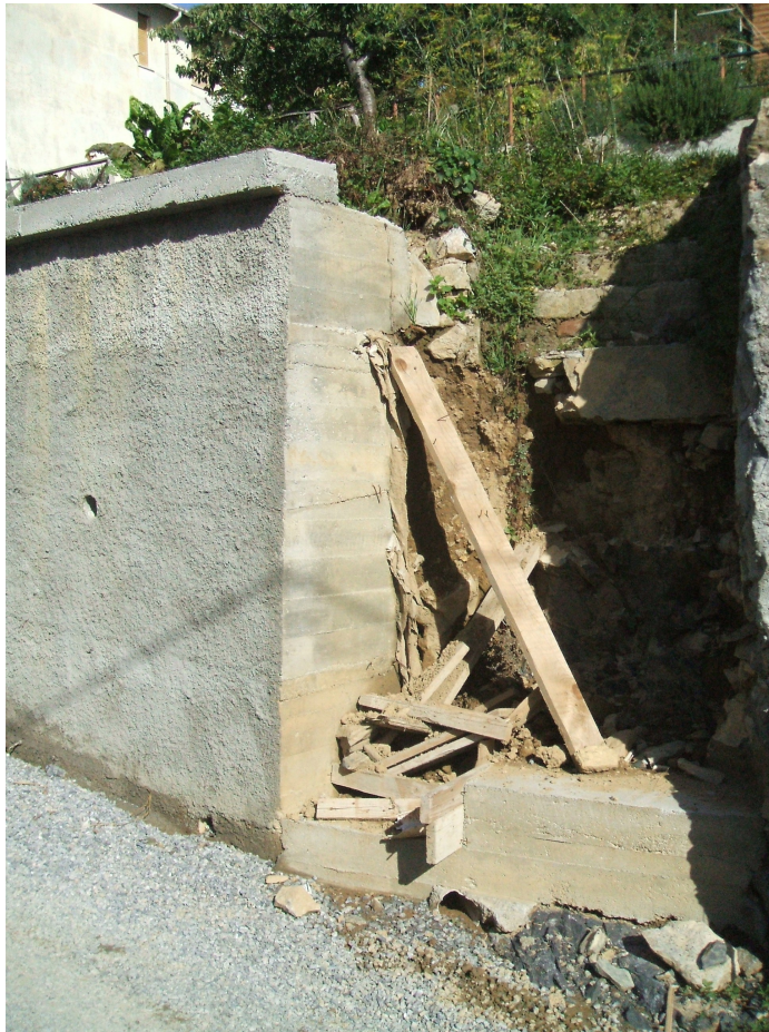
Il muro di sostegno della strada realizzato in unica gettata sui muretti a secco esistenti! (visuale frontale)
