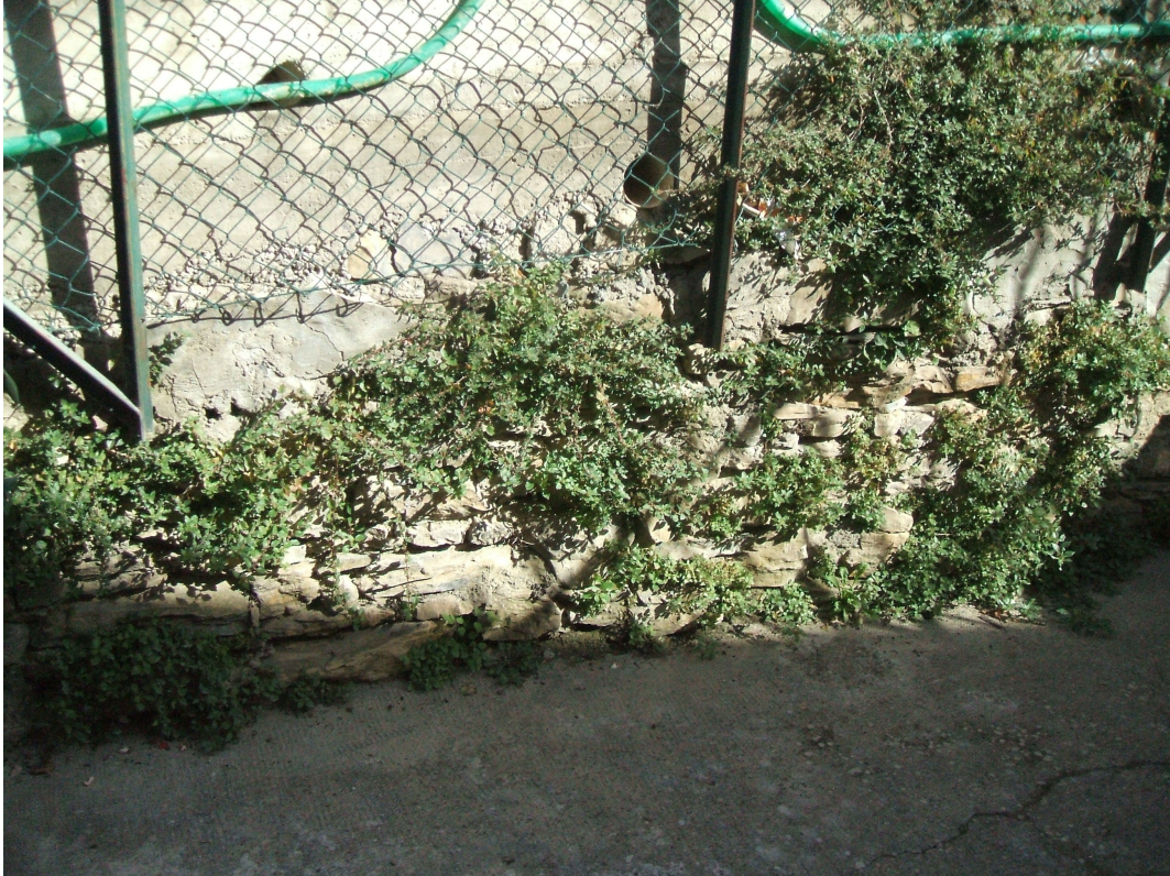
Il muro di sostegno della strada realizzato in unica gettata sui muretti a secco esistenti! (visuale frontale)
