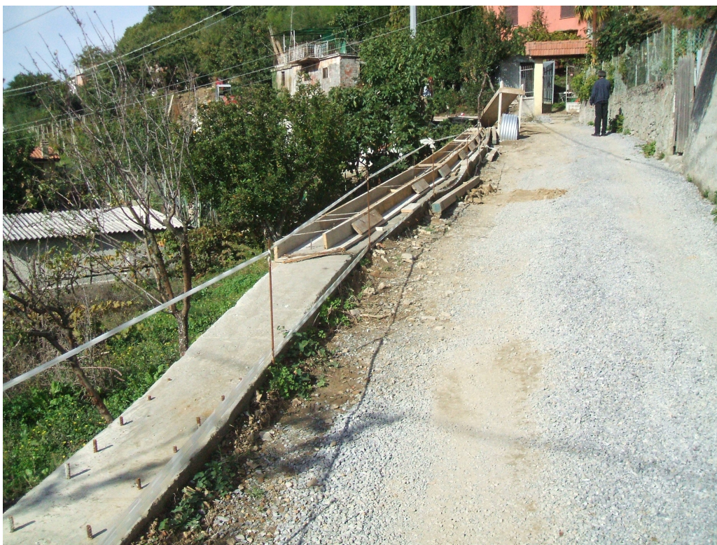
L'unica protezione è un nastro. A parte i cartelli fotografati non vi è alcuna segnalazione del cantiere e dei mezzi in movimento, nemmeno prima dell'entrata nella strada lungo la strada principale! (manca anche il bagno a servizio del cantiere, previsto dalla normativa)
