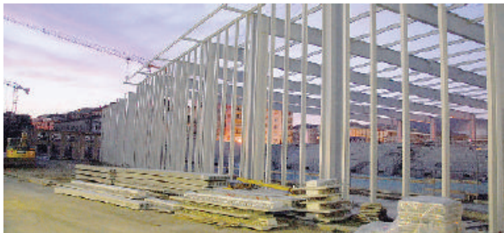
I lavori per la copertura della piscina di corso Colombo sono in elevato stato di avanzamento
